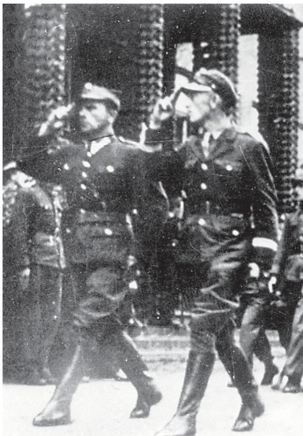
Defilada przed głównym wejściem do budynku dydaktycznego od strony Słupii.
