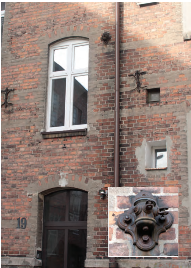
fot. Kotwa na kamienicy w pobliżu nieistniejących już garaży tramwajowych.
