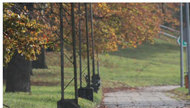
fot. Słupy trakcyjne przy ulicy Kaszubskiej.
