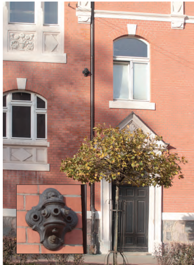
fot. Kotwa na budynku Starostwa Powiatowego.
