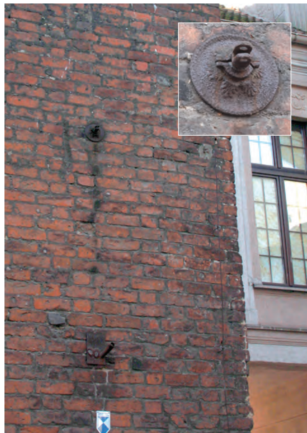
fot. Kotwa na Nowej Bramie.
