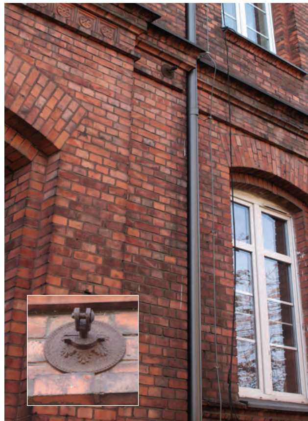
fot. Kotwy na budynku Szkoły Podstawowej nr 2.
