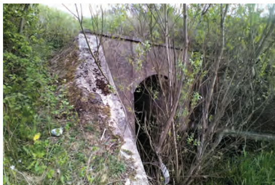
Wjazd do tunelu od strony dawnego wysypiska śmieci.
