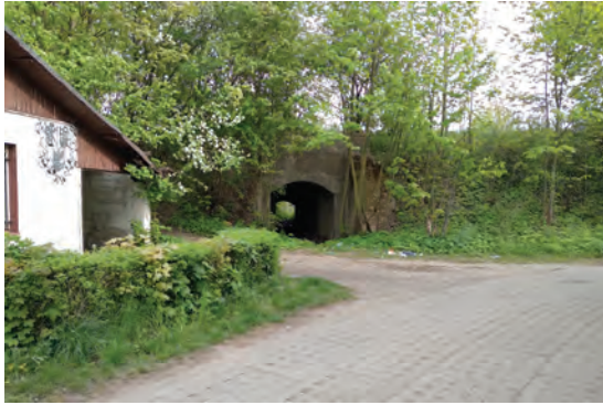
Wjazd do tunelu od strony ul. Borcharta
