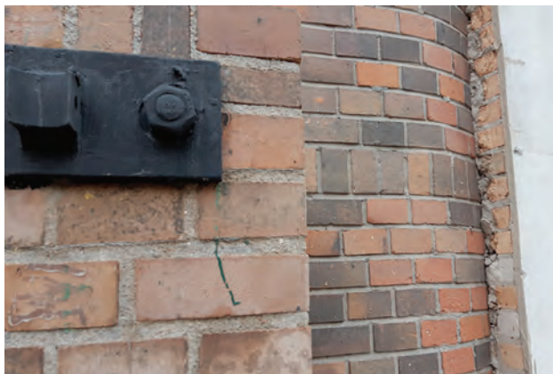
fot. Fragmenty uchwyty bramy i nie dość starannie zamurowany wjazd.
