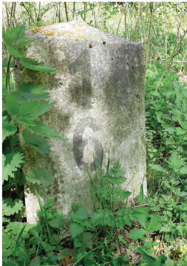
fot. Słupek hektometryczny - Od rozjazdy w Jezierzycach mamy tu 1,6 km
