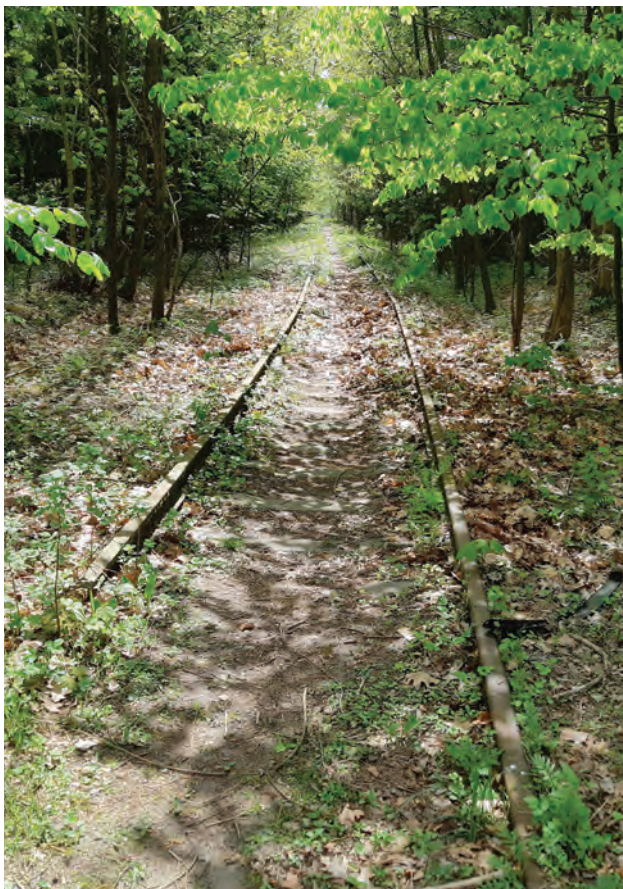
fot. Leśny odcinek linii z Jezierzyc do lotniska w Redzikowie
